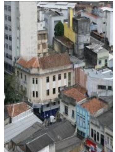
Figura 13: Vista superior dos prédios centrais de Campina Grande. Fonte: Autor, 2013.
