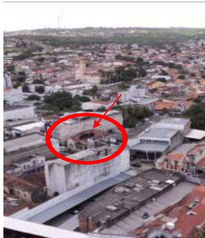
Figura 12: Desabamento de telhado no centro. Fonte: Autor, 2013.
