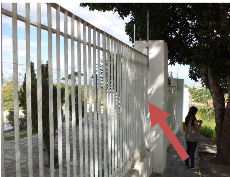
Figura 04: Muro com gradil de ferro e cerca elétrica
